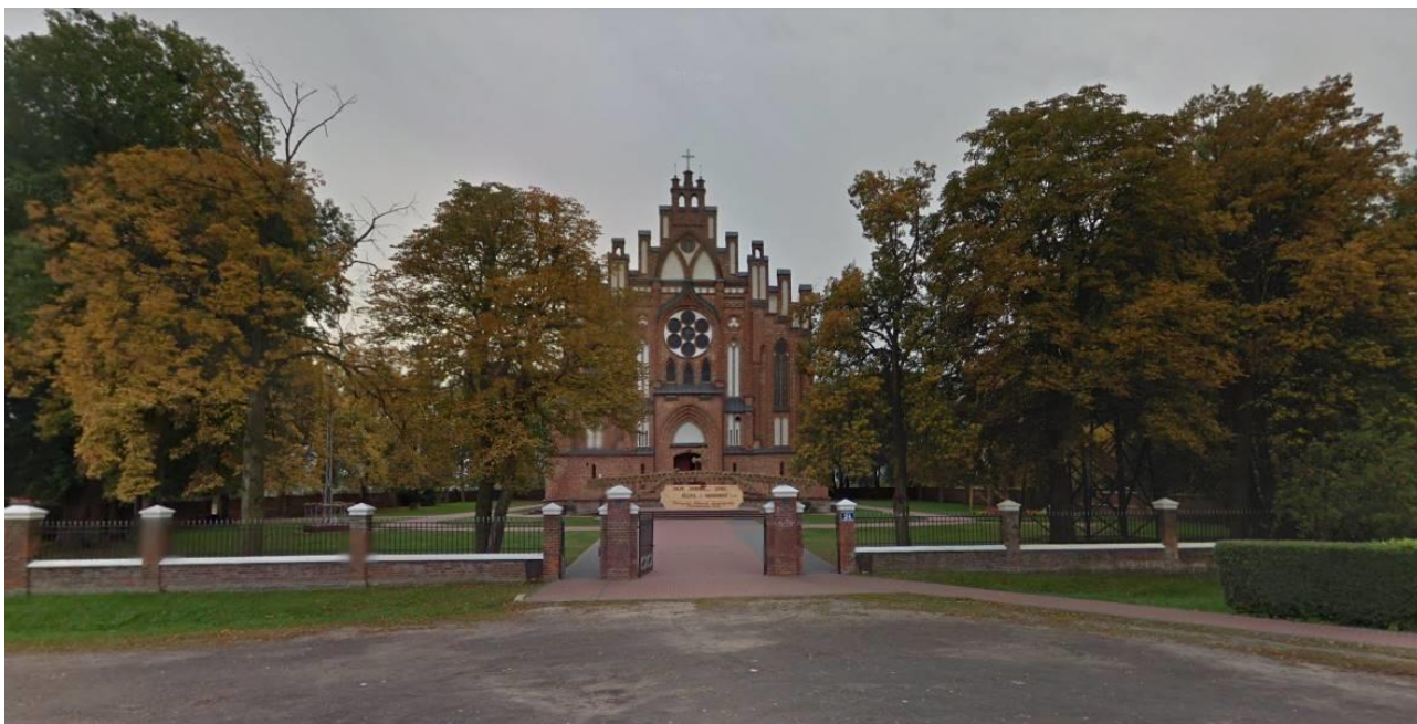
Fotografia 35 Zabytkowy kościół par. pw. Niepokalanego Poczęcia NMP w Kamionnej
