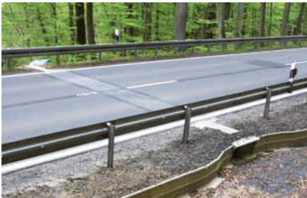
Fotografia 29 Przykład wykonania tunelu dla płazów z systemem naprowadzania
