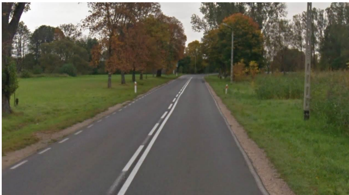
Fotografia 27 Przebieg drogi krajowej nr 62 w rejonie siedlisk płazów (km 0+500)
