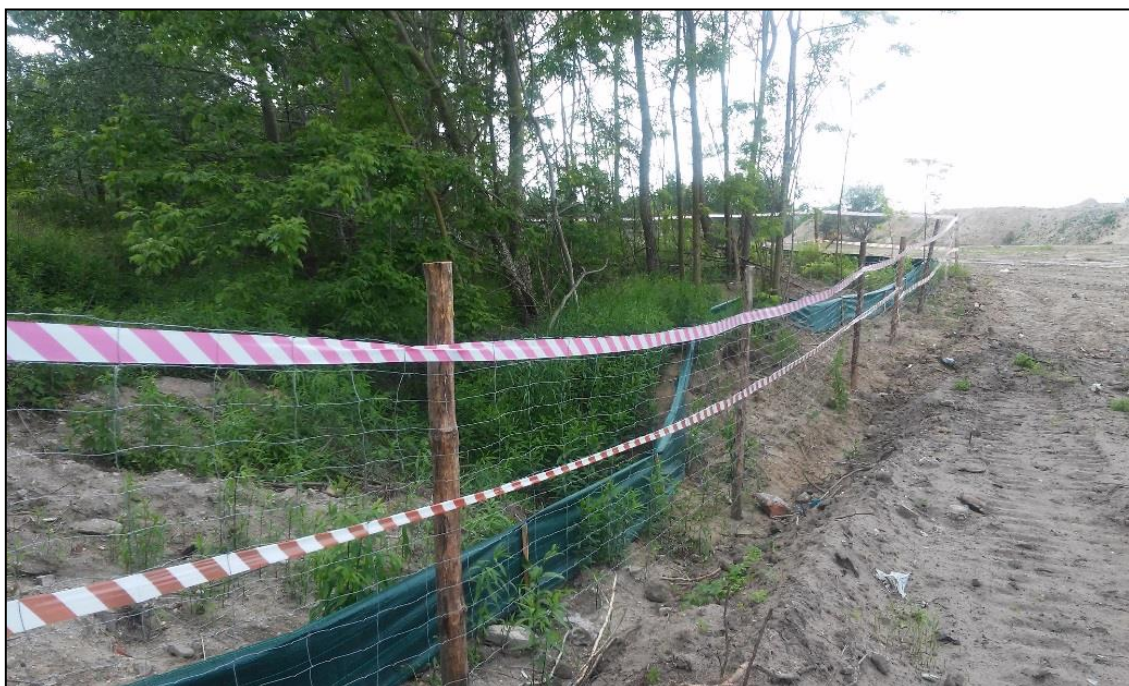
Fotografia 30 Przykład wykonania tymczasowych wygradzeń dla płazów
