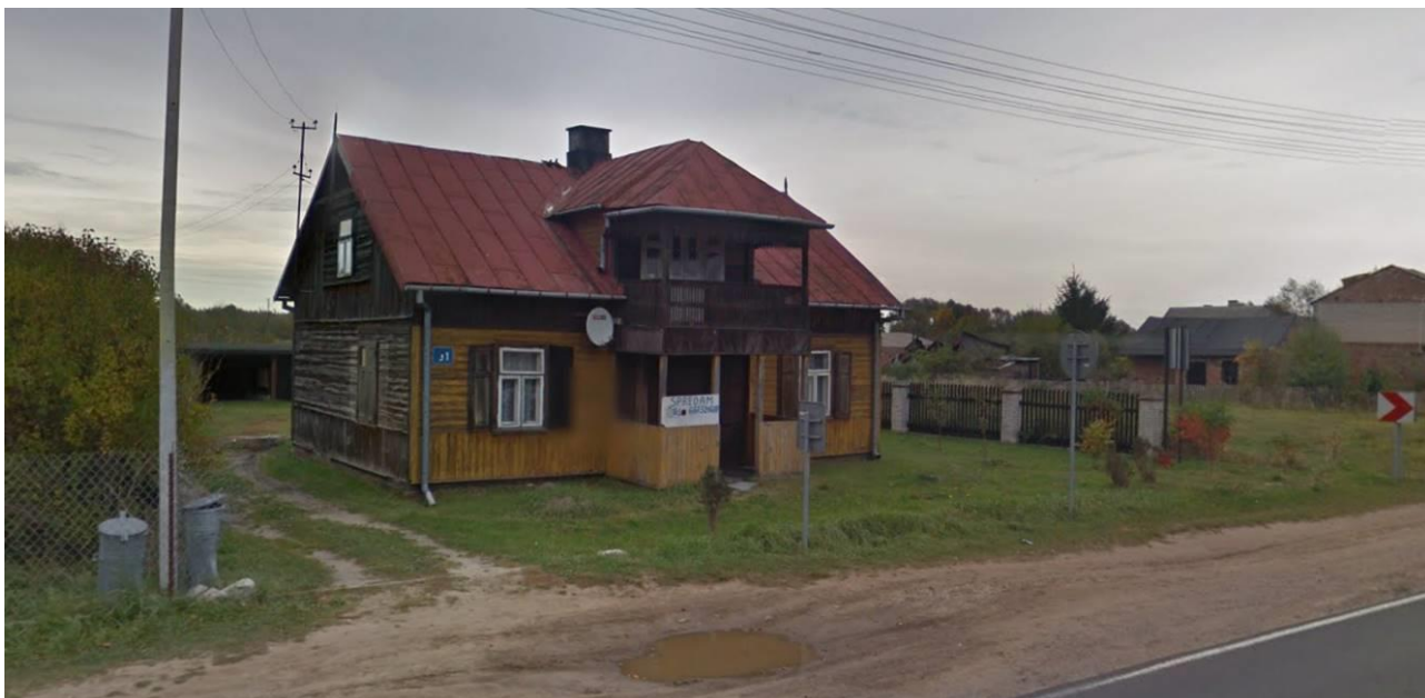
Fotografia 38 Wpisany do gminnej ewidencji zabytków dom drewniany kolidujący z analizowaną inwestycją – zdjęcie archiwalne z 2013 r. – budynek został wyburzony
