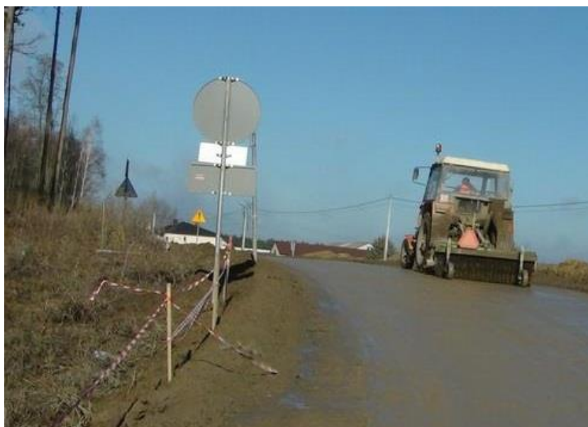
Fotografia 3 Czyszczenie dróg dojazdowych
